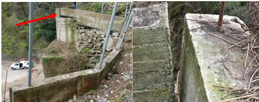
Figura 14 – A sx., vista laterale del cordolo rinvenuto a seguito della pulizia. A dx., dettaglio della disconnessione tra gli elementi costituenti il cordolo.
