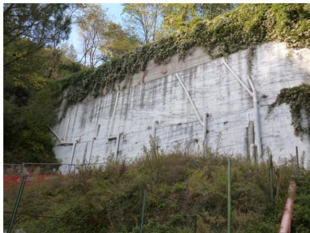
*Figura 3 – vista della briglia di contenimento del corpo rifiuti*
