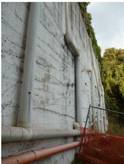
*Figura 2 – vista delle tubazioni aeree in PVC sulla briglia di contenimento*
